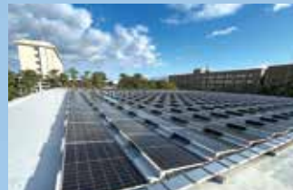
新潟大学 五十嵐キャンパス 太陽光発電設備工事
