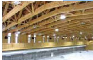
村上市スケートボードパーク 電気設備工事
