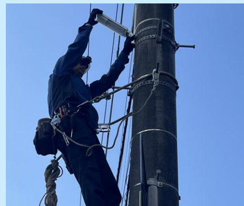
「町内 防犯灯取替工事」(鈴木満弦) LEDはさらに進化して、より明るくより消費電力の少ない効率の良いものになってきています。このLED工事を通して、町内をより安全に明るく照らしていけたらと願いながら作業を行いました。
