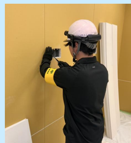
「ビル 配線・ボックス開口工事」(山本) 開口する部分を間違えないようにしっかり寸法を確かめながらボード開口を行いました。
