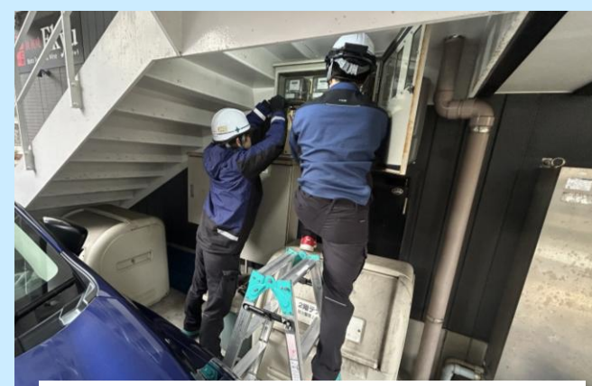
「テナントビル 電力量計交換工事」(鈴木晃) 4階建てテナントビルにて古くなった電力メーターの交換を行いました。接続間違いが無いよう注意して作業を行いました。
