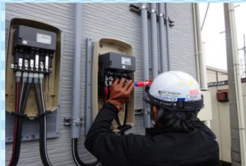
**作業所 電力積算メーター取替作業(阿達)**
