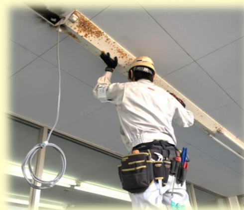
商業施設 照明器具交換工事(木村) 老朽化などで点かなくなったり、漏電が起きた照明器具の交換を行っています
