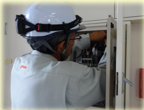
福祉施設 分電盤配線接続作業(阿達) 分電盤へ集めた配線を各ブレーカへ接続していきます
