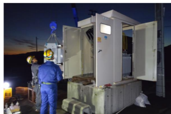
高圧設備更新工事 (新潟県五泉市内) 経年劣化した高圧設備機器(建物の心臓部)を新しい機器に取り替える工事を行いました。担当:石井、阿達
