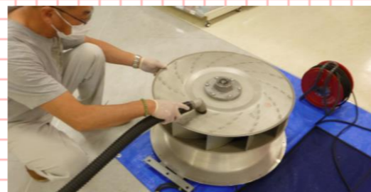
空調機洗浄作業 (新潟県新潟市内、長岡市内) ショッピングセンターの空調機(ファンコイルユニット)のクリーニング作業を行いました。担当:木村、内山
