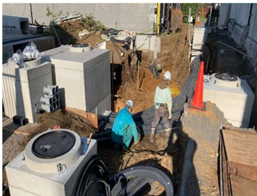
ハンドホール設置後 幹線管路埋設工事
