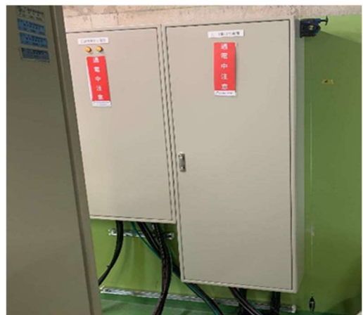
新規設置した電灯・動力盤
