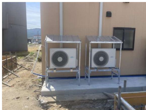
室外機は架台を組んで持ち上げる
