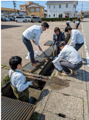
側溝清掃の様子
