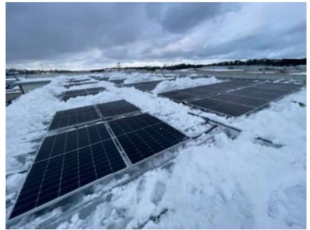
パネルの離隔部分に雪を積上げる
