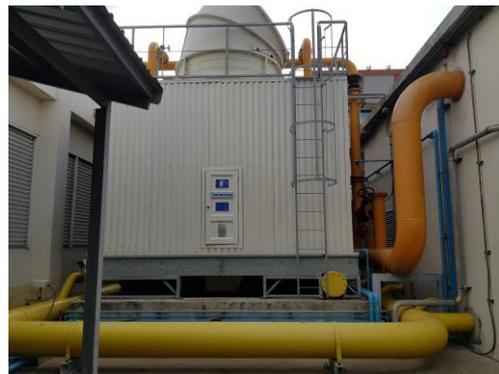
インバータ制御対象の冷却塔（ファン）
