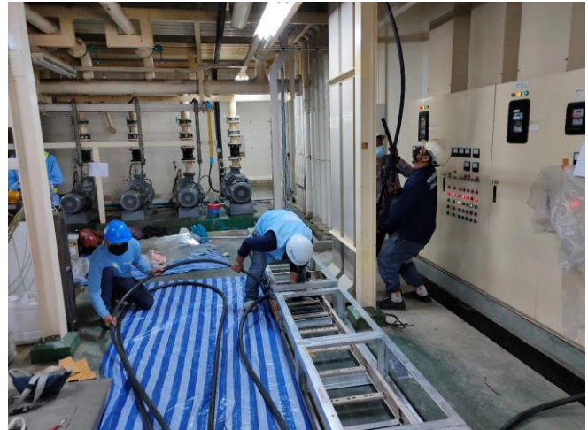
図2 作業状況（遠隔監視にて）
