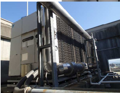
上：エコ・ビジョン盤 下：ヒートポンプチャラー
