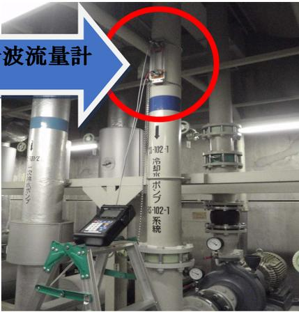
・超音波流量計を使った測定
