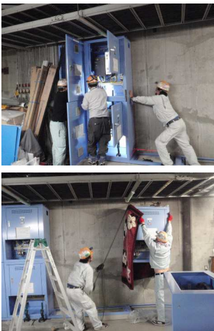
盤搬入据付作業の様子
